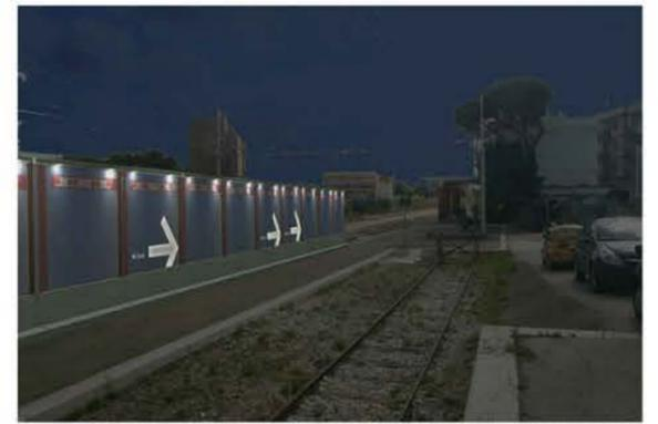
VISTA NOTTURNA DELLE BARRIERE CON APPLICAZIONE DI VERNICE FLUORESCENTE
